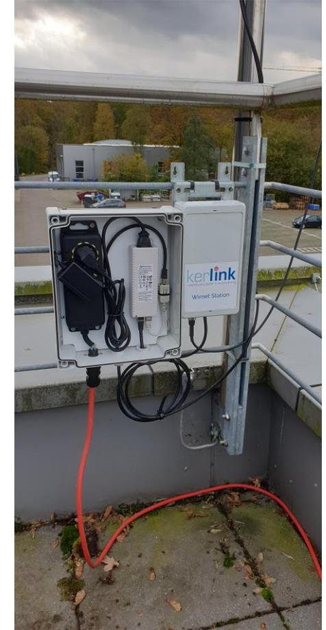
Aufbau eine Gateway-Stationes zur Übertragung der Sensordaten in das Internet
